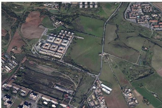
Veduta aerea del comprensorio
